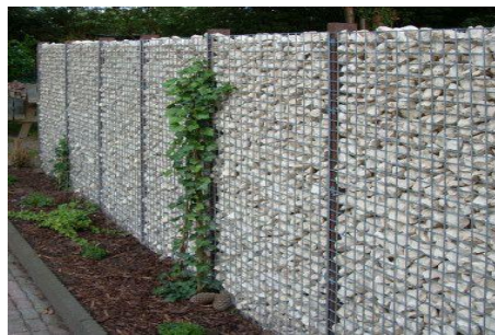
Figura 2: Módulos usado de muro perimetral
